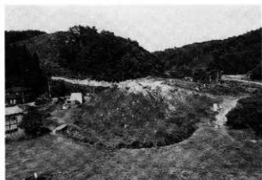
1区雑物撤去後（南から）
