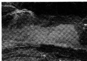
2区西側雑物撤去後（北から）
