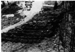
試掘風景（北西から）
