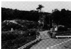
ふみ切り現況（東から）
