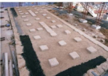
改良土および礎石・布石施工完了
