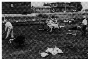
西区作業風景（東から）
