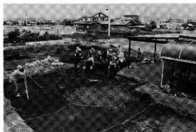
北東区作業風景（南西から）
