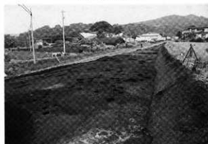
II層面（第1検出面）全景（西から）
