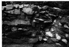
地下構造北～東壁 (南から)
