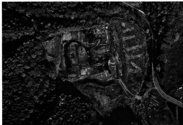
遺跡全景（南から※平成20年11月撮影）
