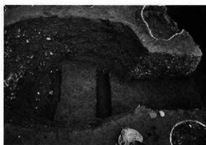
地下構造掘り方最終段階（南から）
