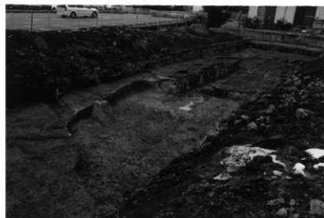
第3区北側全景（南東から）
