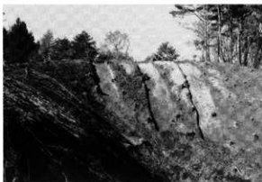
東谷①調査終了後（東から）
