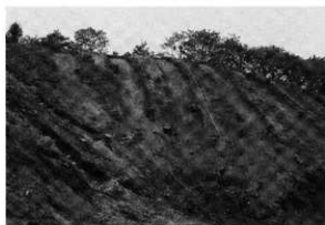
斜面部調査状況 (南から)
