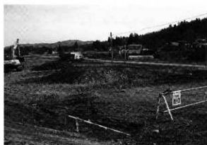
調査前（南から）
