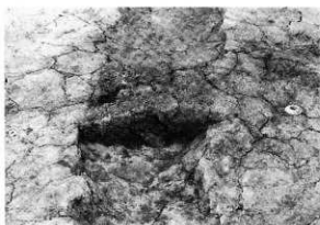
同左断面 (東から)
