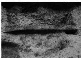
RG322 溝跡断面 (南から)
