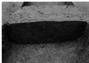
4号溝南側断面 (SE→)
