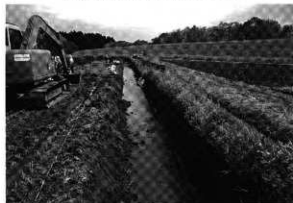
中央部調査区T11④検出面（北から）
