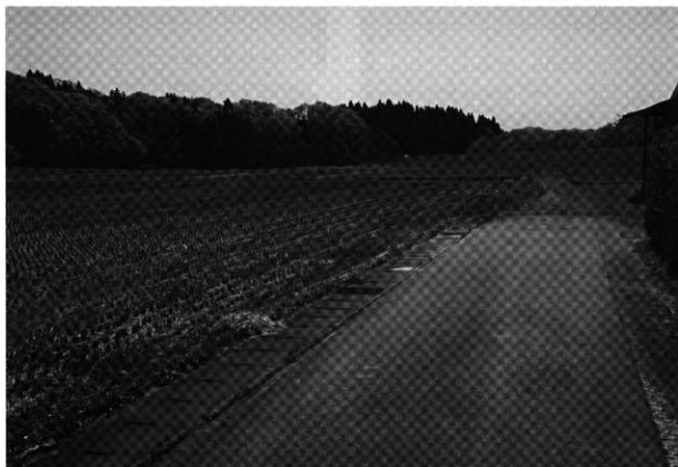
道跡近景（北から）
