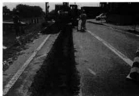
作業風景（左側が史跡浪岡城跡）
