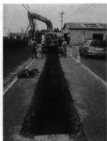
SH01・SH02・SH03 確認状態
