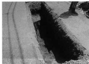
SH04完掘状況（西から）
