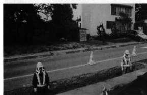
SH01堀幅（作業員間、南から）
