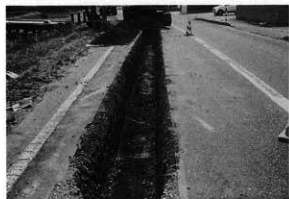
舗装除去状態
