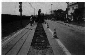
調査状況（舗装除去）
