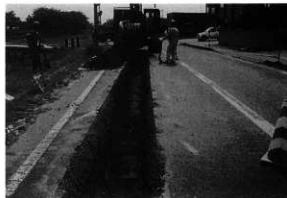
作業風景（左側が史跡浪岡城跡）
