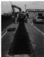
SH01・SH02・SH03 確認状態
