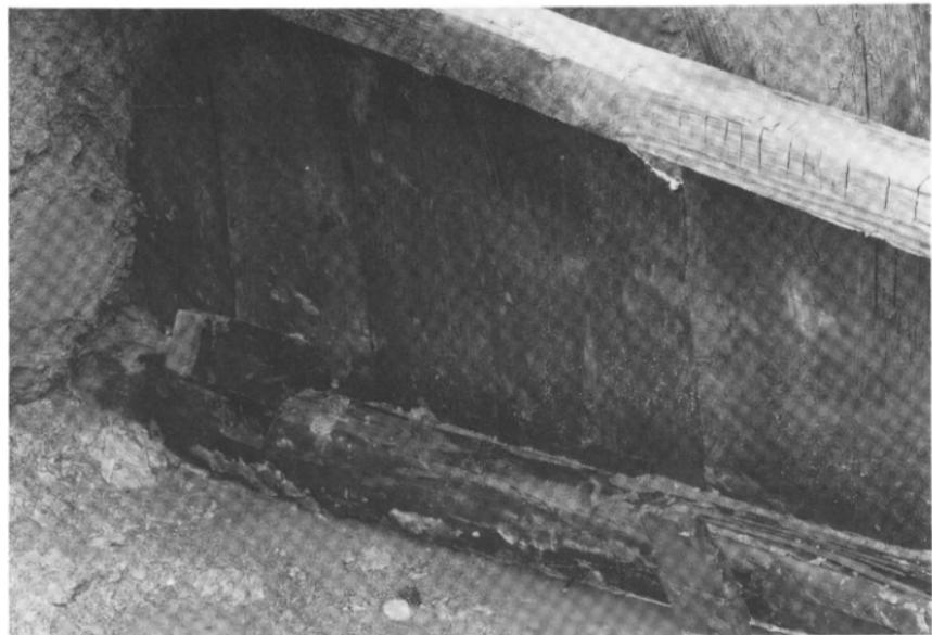
B区北面底辺板柵下端の仕組み
