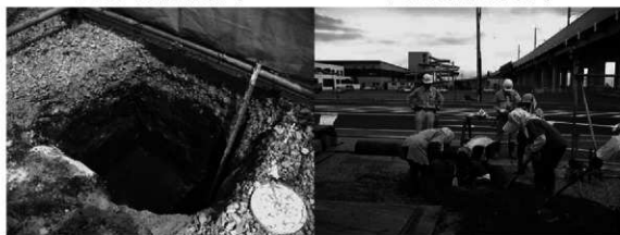
トレンチ3 確認状況 (SE→)
