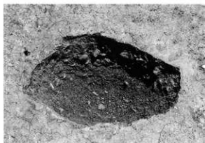
RD2059全景 (西から)
