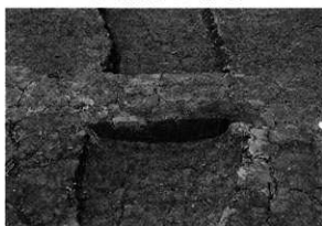
RG580断面 (南東から)
