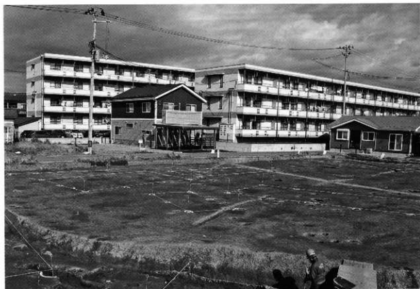
RB084~087付近全景（南西から）
