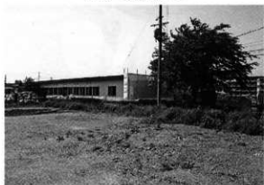
調査前・南西側 (南東から)
