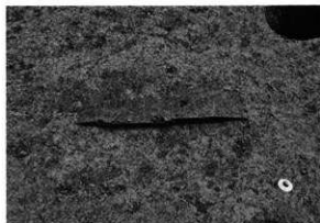
RD2046断面 (西から)
