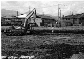
重機による粗掘 (東から)
