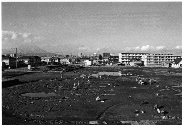
RB134~139付近作業風景（南から）
