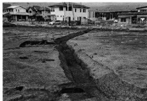
RG461北側（南東から）
