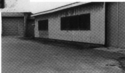
(3) C区調査前状況 (南から)
