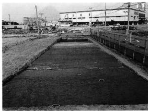
V区全景 (西から)
