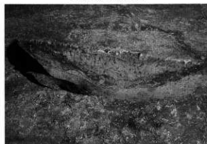
S K04断面 (南東から)
