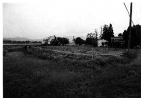
A区調査前現況 (北西から)
