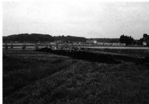
A区表土掘削風景（南から）
