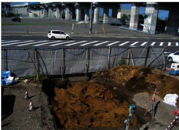
写真3-28 トレンチ4調査区風景(S→)
