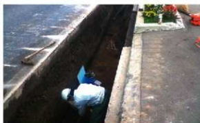
写真1-66 C地点トレンチ2作業風景(W→)
