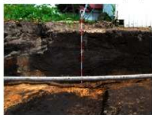
写真1-40 13-0110セクション2(W→)
