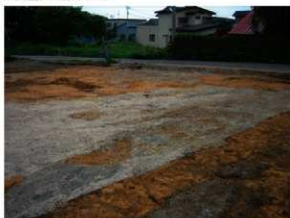
写真1-34 D区調査区風景
