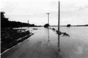
冠水した調査区 (7月12日午前)
