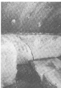
写真-138 炉下半月鉄板脚部(中央部分)
