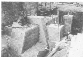
写真-54 基礎工事 第二工区
