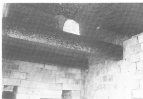
写真-229 ロストル受け桁（南B炉）
