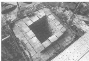
写真-163 煙突中段肩部（南炉）
