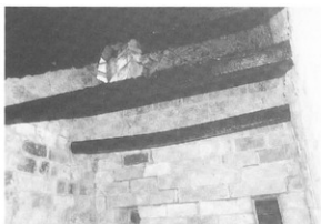
写真-228 ロストル受け桁（南A炉）
