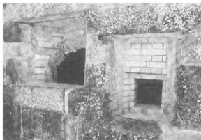
写真-153 炉体外観（南炉）
