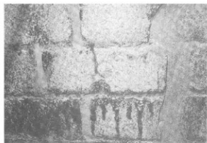
写真-181 煙突内部 (南B炉)
