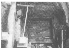
写真-186 鑄台完掘の状況
