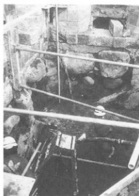
写真-123 湯口側基礎調査状況
