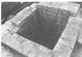
写真-162 煙突中段肩部（北炉）
