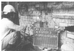
写真-38 既存補強鉄骨解体工事
