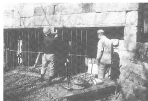
写真-45 南炉下焚口鉄格子解体
