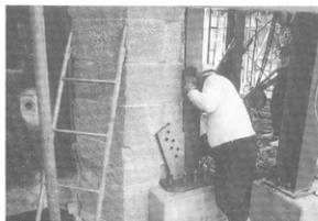
写真-85 補強用鉄骨(組立)
