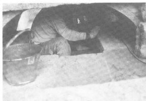
写真-68 炉下東石補強工事
