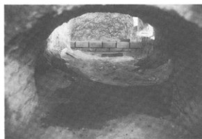
写真-70 炉床三和土欠損部補修
