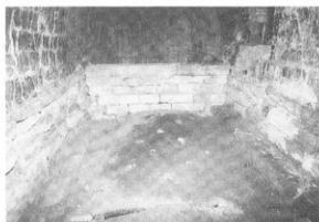
写真-149 炉内（南A炉焚口側）
