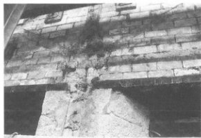
写真-40 既存補強鉄骨解体後
