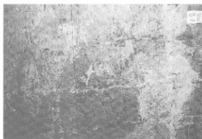
写真-176 煙突内部 (北A炉)
