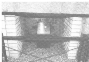
写真-119 内柵、サイン設置後（灰穴）
