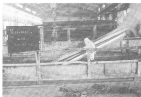
写真-81 補強用鉄骨 (亜鉛メッキ処理)
