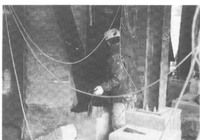
写真-88 補強用鉄骨(仕上塗装)
