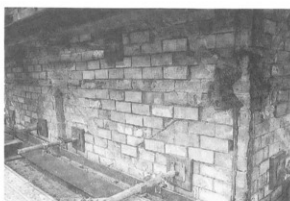
写真-31 補強ジャッキ(煉瓦面支持)
