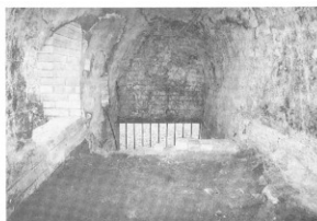
写真-147 炉内（北B炉焚口側）
