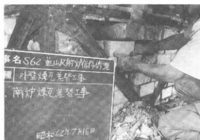
写真-95 煉瓦取付け
