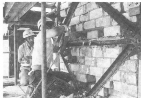
写真-94 既存煉瓦撤去
