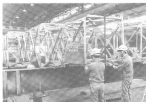
写真-82 補強用鉄骨 (仮組み)
