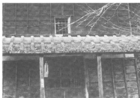
写真-231 江川邸 倉の入口庇
