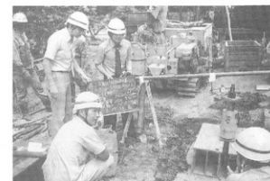
写真-49 アースアンカー工事 (耐力試験)
