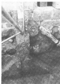
写真-125 南炉基礎部分
