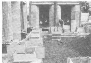
写真-61 基礎工事 第四工区 (アンカー先端部保護)
