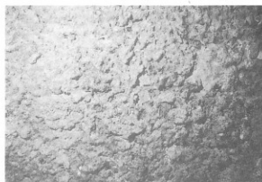
写真-178 煙突内部 (北B炉)
