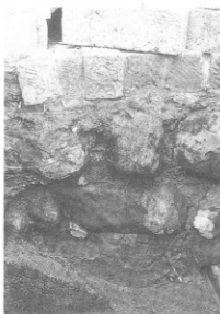
写真-124 北A炉基礎部分
