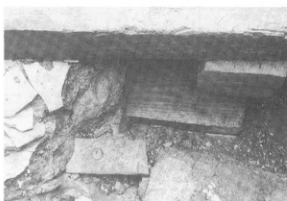
写真-190 鑄台床面下の状況
