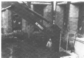
写真-56 基礎工事 第四工区 (掘削)
