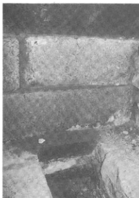
写真-137 炉下半月鉄板脚部(外側)
