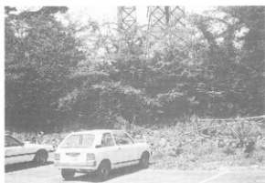
写真-115 外柵 設置前
