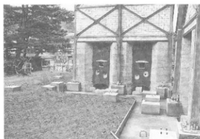
写真-58 基礎工事 第四工区
