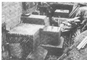
写真-55 基礎工事 第三工区
