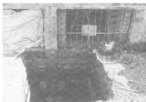
写真-129 下焚口側基礎調査箇所（北炉）
