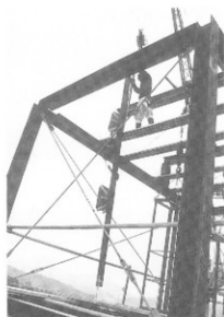
写真-84 補強用鉄骨 (組立)
