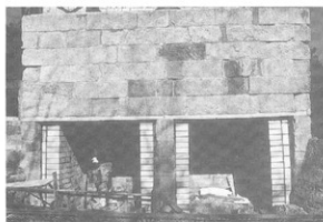
写真-76 下焚口煉瓦積み修復
