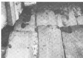
写真-189 鑄台床面の焦げ跡
