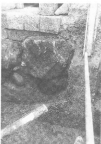
写真-126 南B炉基礎部分
