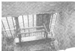
写真-43 北炉下焚口赤煉瓦控柱荷重調査
