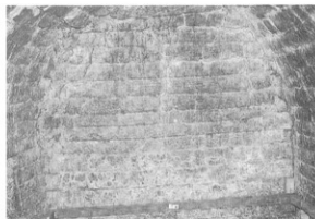
写真-151 炉内（南B炉焚口側）
