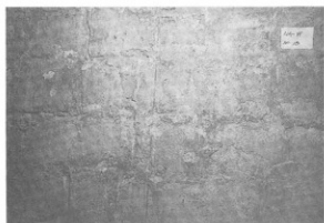
写真-175 煙突内部 (北A炉)
