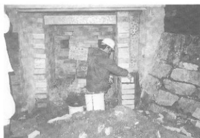
写真-75 下焚口煉瓦積み修復
