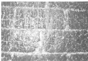
写真-182 煙突内部 (南B炉)
