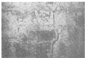
写真-177 煙突内部 (北B炉)
