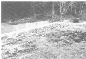
写真-65 伊豆石補強工事（アンカー筋）
