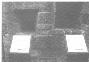
写真-118 内柵、サイン設置後（鑄口）
