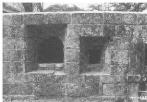
写真-152 炉体外観（北炉）
