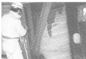
写真-74 伊豆石の劣化防止
