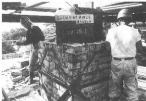
写真-41 煙突最上部解体
