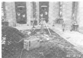
写真-60 基礎工事 第四工区 (アンカー耐力確認)
