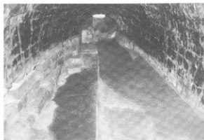
写真-73 炉床三和土欠損部補修（南A炉）
