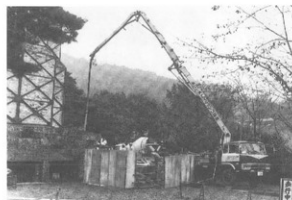
写真-52 基礎工事 第一工区（コンクリート打設）
