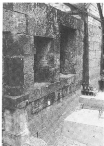
写真-154 炉体外観（基礎掘削時）
