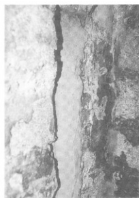
写真-106 煙突内部亀裂補修後
