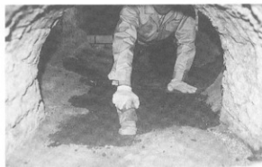
写真-71 炉床三和土欠損部補修
