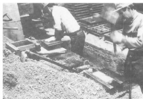
写真-90 煉瓦製作(成型)
