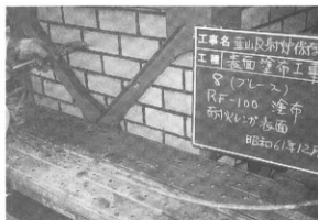
写真-104 外壁煉瓦劣化防止
