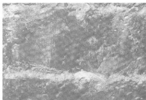
写真-180 煙突内部 (南A炉)
