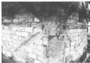
写真-39 既存補強鉄骨解体後
