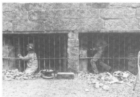
写真-44 北炉下焚口赤煉瓦控柱解体後
