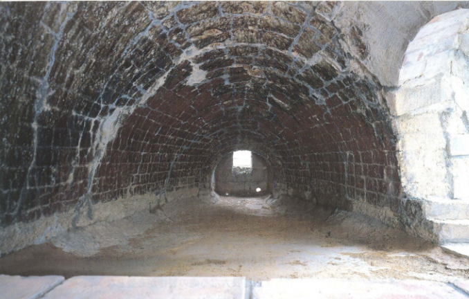
写真-2 伊内 (南B炉の中 から出湯口 側を見る)
