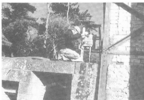
写真-64 伊豆石補強工事（穿孔）
