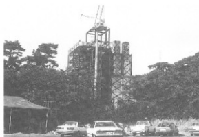
写真-28 特殊仮設鉄骨(北炉)
