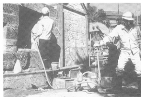
写真-62 炉体部注入補強工事（注入）
