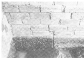
写真-134 下焚口側基礎（南B炉）
