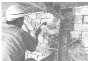
写真-101 漆喰保存修理
