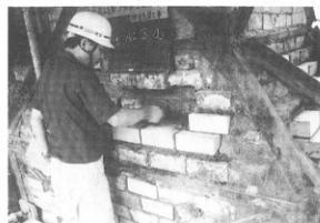
写真-96 煉瓦取付け
