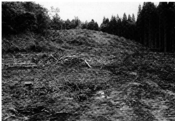
尾根部現況（南から）
