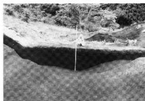
谷部断面 (南から)
