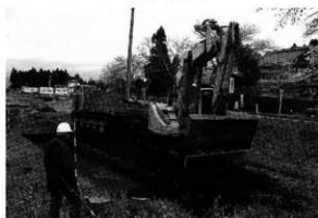
3①区重機による表土掘削
