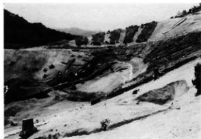
南尾根トレンチ掘削状況
