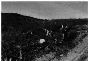
雑木撤去作業
