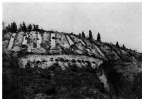
西斜面トレンチ掘削状況
