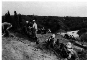
切株除去作業
