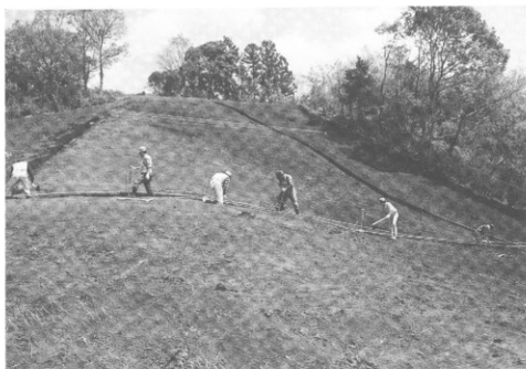
第 3 トレンチ掘削作業風景
