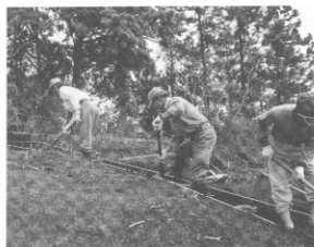
第1トレンチ掘削作業風景
