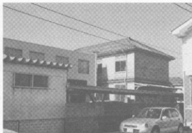
2 庁舎南面と東面遠景 南東から
