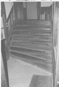
6 階段室と階段 東から
