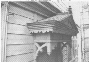
7 庁舎正面玄関庇 南西から
