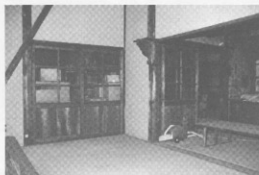
3 宿直室(手前:北部屋) 北西から
