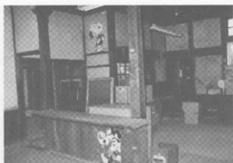
2 執務室カウンターと執務室 南東から
