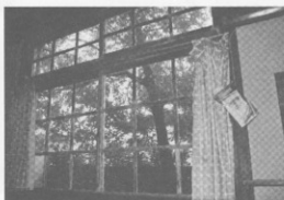
4 宿直室北部屋窓 南東から
