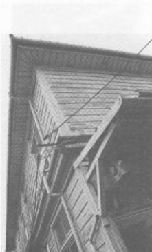
3 屋根裏面の状況 南東隅部
