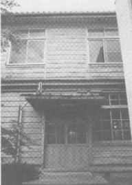
5 階段室入口 南から
