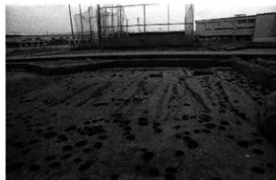
4区南半完掘状況(北から)
