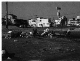
遺構掘削作業
