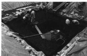
人力掘削作業
