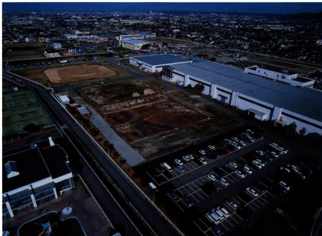
調査区南側全景(南西から)
