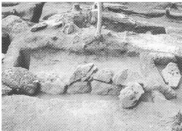
2 前面トレンチ(西側)列石検出状況(南から)
