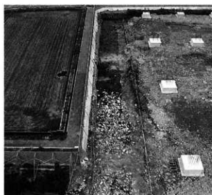
② A区北端 (西より)
