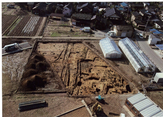
第20次全景(東から)
