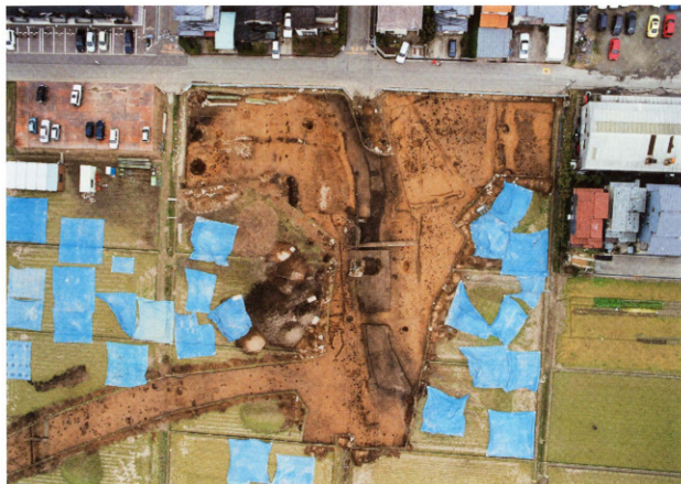
第6次全景(上空から)
