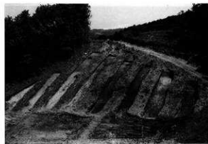
T32～39掘削状況 (南東から)
