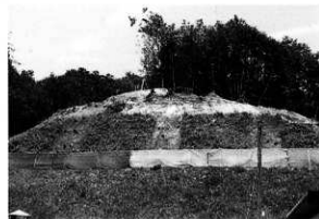
T45～47掘削状況 (南西から)
