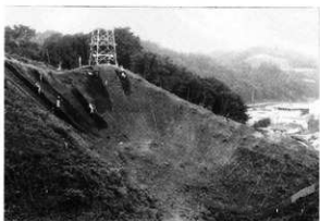
試掘作業風景
