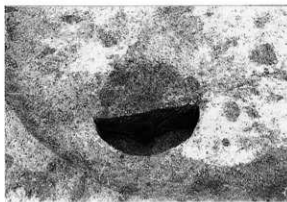
P 1 断面（南西から）
