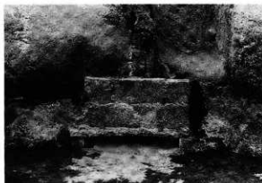
SW01-煙道 側面 (南から)
