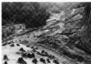
3区谷部 全景 (北から)
