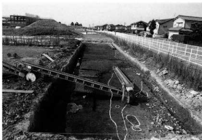
河川SA(3)(B区) 検出(南から)
