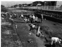
SA(3)河川掘削
