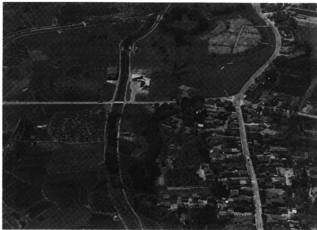
新館の航空写真（東側から）
