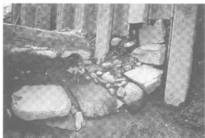
第7図 堀南岸護岸の様子
