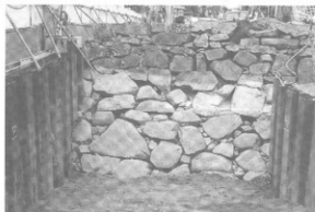
第2図 石垣上半部
