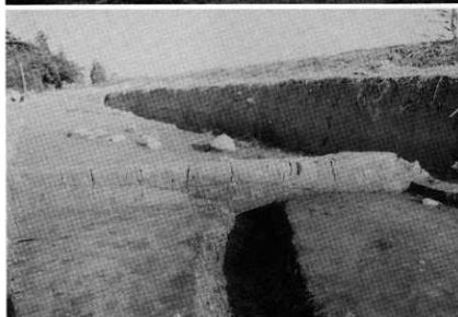
3. SD13土層断面(西から)
