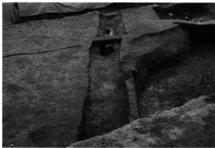
1. SD07 溝跡完掘状況 (北から)
