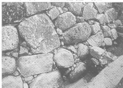
第6図 D地点大納戸櫓台石垣の基部
