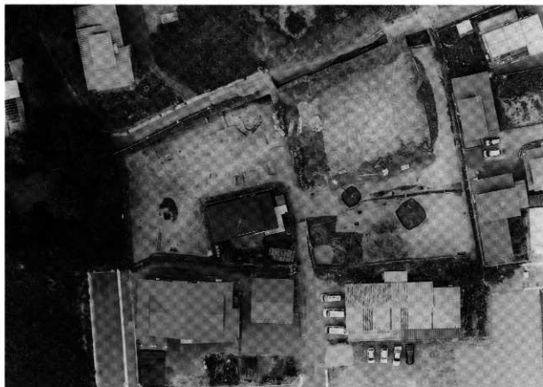
Ⅱ区近景(直上・写真上が北)
