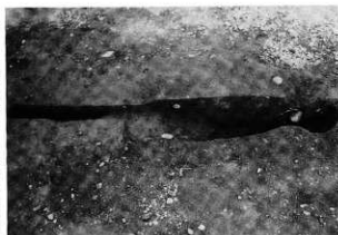
煙道断面(南から)
