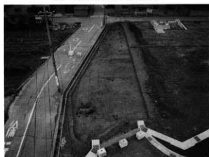
C2区完掘状況 (南より)
