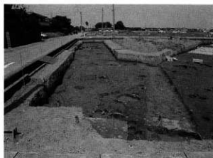
6区全景 (南より)
