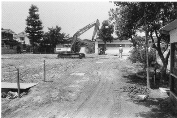
調査前全景（東より）
