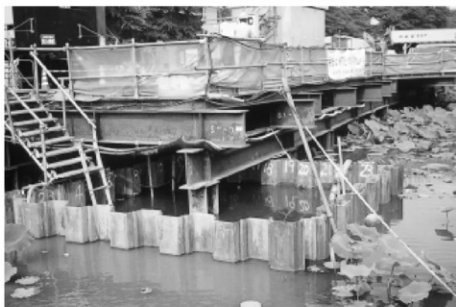
久保田城堀地区 大手門堀立坑 No.1調査前
