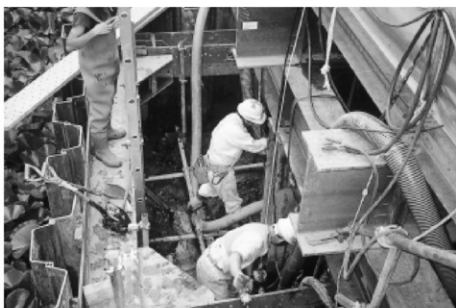
久保田城堀地区 大手門堀立坑 No.3作業風景
