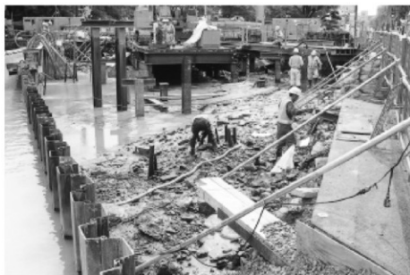
久保田城堀地区 穴門堀調査風景 (西から)
