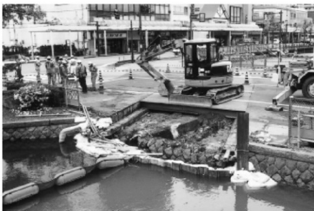
久保田城中土橋地区 第1トレンチ調査風景 (北東から)
