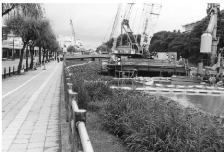
久保田城堀地区 大手門堀調査区全景 (東から)
