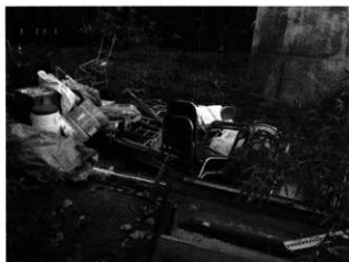
1. 機材搬入状況
