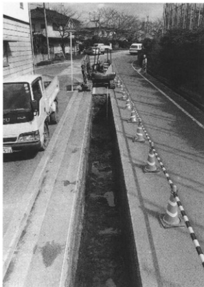
写真1 T7完掘状況（西より）
