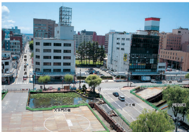
久保田城跡から東根小屋町通をのぞむ（北から）
