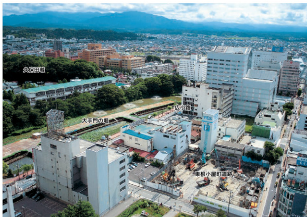
久保田城跡と東根小屋町遺跡（南西から）
