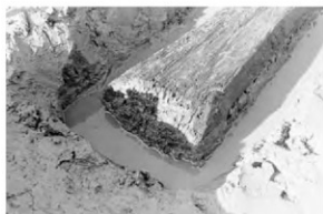
SK P 604柱材 端部
