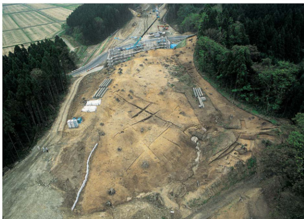
2 平成16年度調査区全景(南西から)
