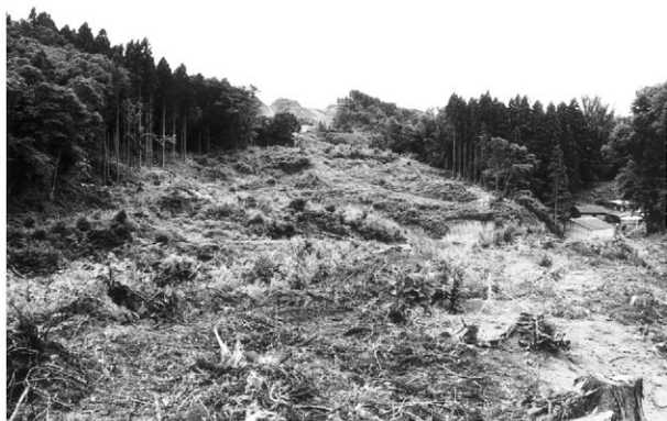
1 調査前状況（北西から）
